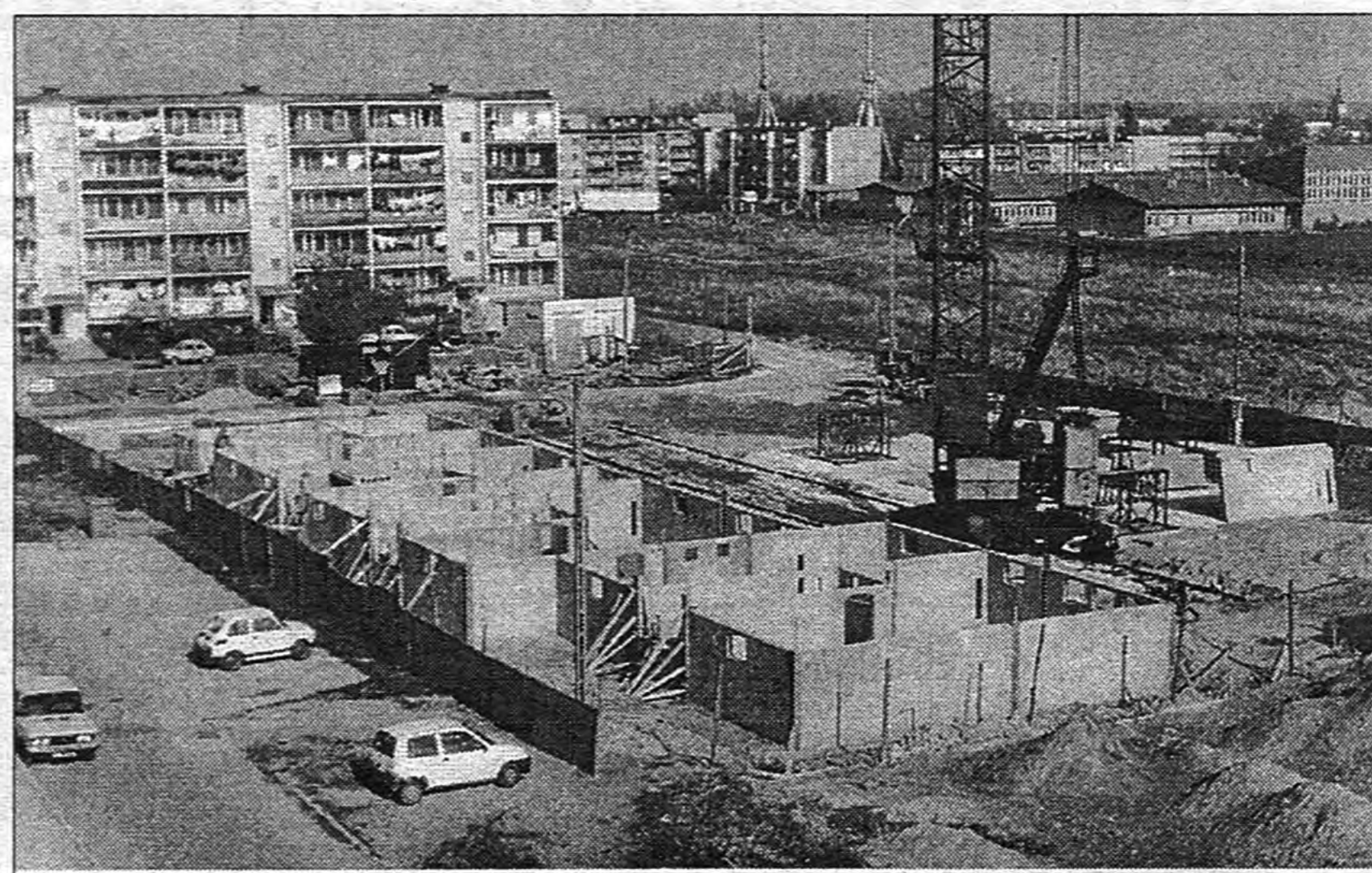
Na osiedlu Bratkowice trwa budowa nowego bloku
