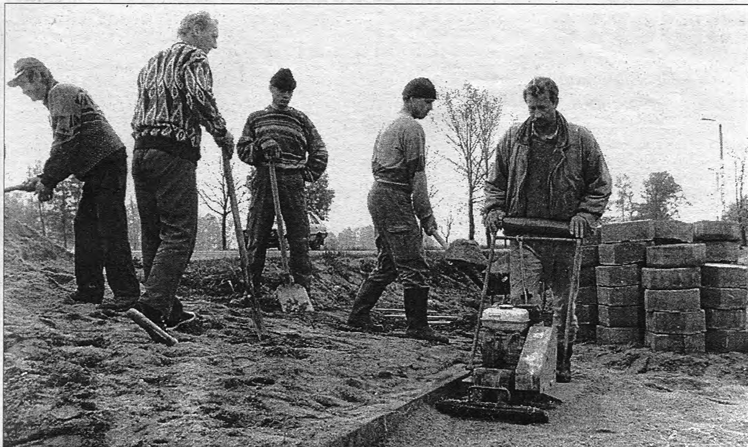
Jamno będzie miało chodnik. Znacznie bezpieczniej, bo nie skrajem ruchliwej szosy, będzie można poruszać się w Jamnie, gdy zostanie oddany do użytku chodnik układany teraz za pieniądze Zarządu Dróg. Chodnik układany jest w tym roku na odcinku 1100 metrów, od szkoły podstawowej do położonego w środku wsi sklepu. W przyszłym roku ułożona będzie druga połowa.
