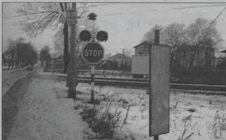
Przed przejazdem kolejowym na ulicy Kiernozkiej ostrzega teraz kierowców również znak STOP.
