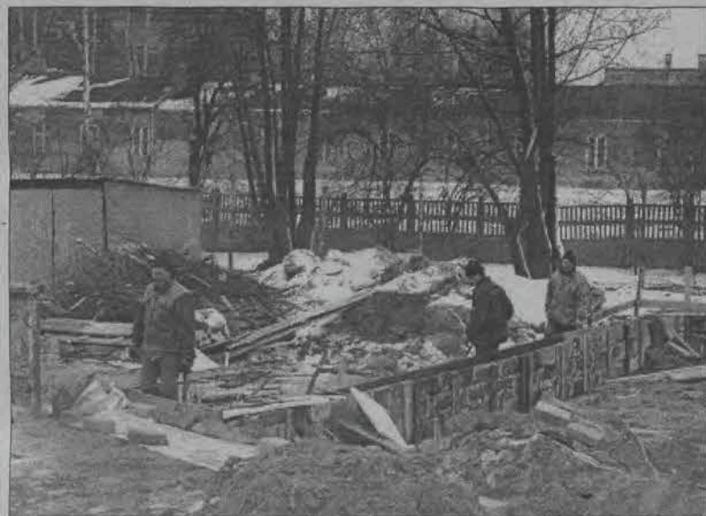
Prace przy fundamentach nowego zaplecza muszli
