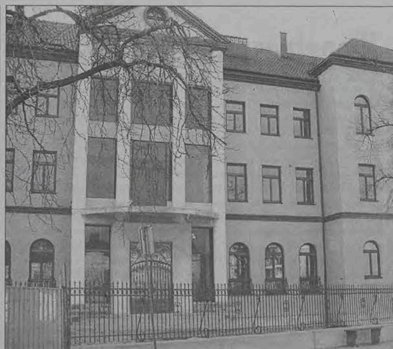
WIDĄC JUŻ KONIEC. Nowy obiekt Mazowieckiej Wyższej Szkoły Humanistyczno-Pedagogicznej w Alejach Sienkiewicza jest już prawie gotowy do otwarcia. Oczom przechodniów ukazało się już kute ogrodzenie budynku, wokół prowadzone są ostatnie prace wykończeniowe.
