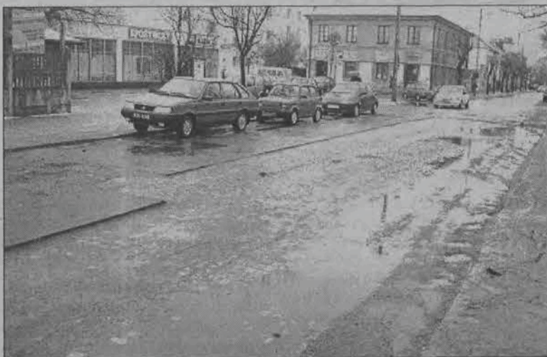
Asfalt ma być zerwany na odcinku od przejazdu kolejowego do skrzyżowania z ul. Tkaczew.
