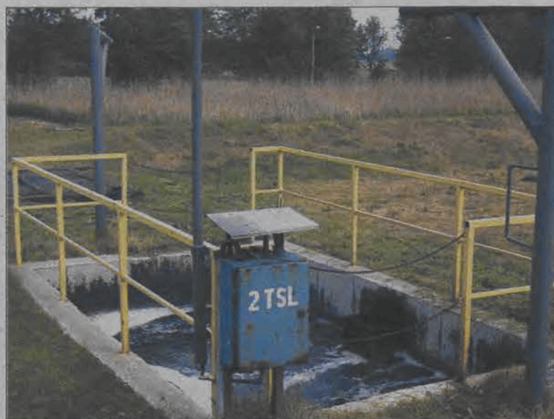
Procesy zachodzące w stawie trzcinowym są przedostatnim etapem oczyszczania ścieków.
