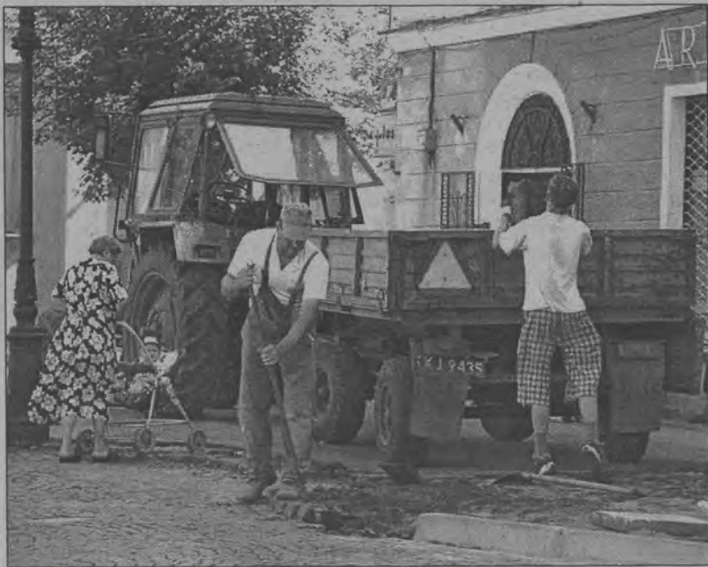
ZUK kończy prace na 11 Listopada, skąd przeniesie się na południową pierzeję Starego Rynku.
