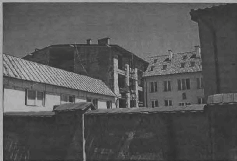
Od strony ul. Chopina widać wyraźnie, że szkoła będzie rozbudowywana w kierunku zachodnim.
