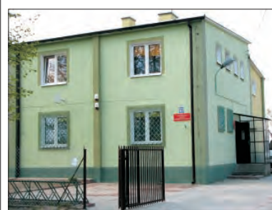
Budynek ma nową, zieloną elewację.
