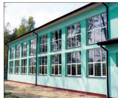
Salę wybudowała w ciągu dwóch lat firma ŁON z Kiernozia.
