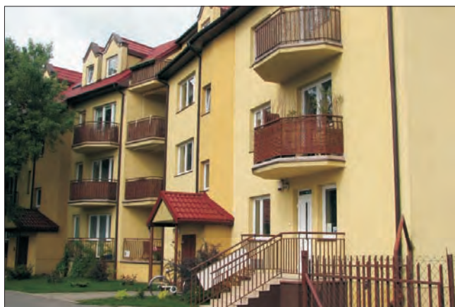
Dom przy ul. Tkaczew - jeden z niewielu przykładów nowego wielorodzinnego budownictwa w Łowiczu.
