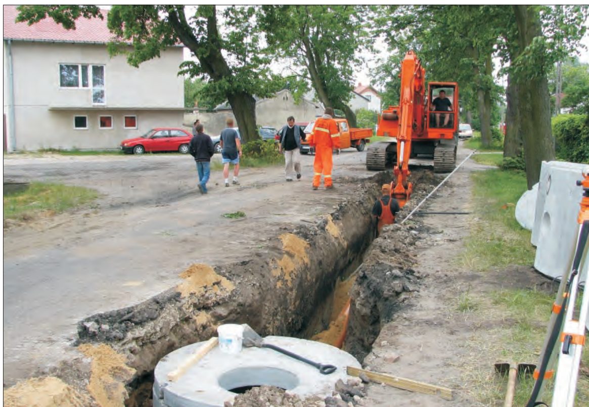
29 maja firma Sławomira Pońskiego z Brzezin rozpoczęła prace przy budowie kanalizacji deszczowej w ul. Kiemozkiej w Łowiczu. Prace kosztować będą 373.594 zł i trwać do połowy lipca. W październiku Kiemozka będzie mieć nową nawierzchnię, chodnik i ścieżkę rowerową. Przetarg na te prace nie została jeszcze przez Urząd Miejski rozstrzygnięty.
