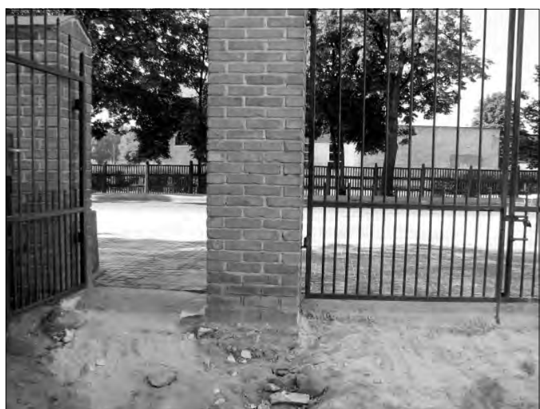
Dopóki nie zakończą się prace instalacyjne na chodniku i nie powstanie chodnik, wejście przy bramie będzie pełne nierówności.
