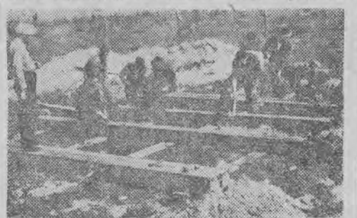
Już postawiony został fundament pod wieżę wiertniczą
