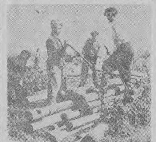
Pracę przy budowie szybu znaleźli również okoliczni mieszkańcy: z lewej do prawej ob. Jan Ślusarczyk, Marcinak ze wsi Piesiekierz Rudy, Jan Kapusta ze wsi Bronie
