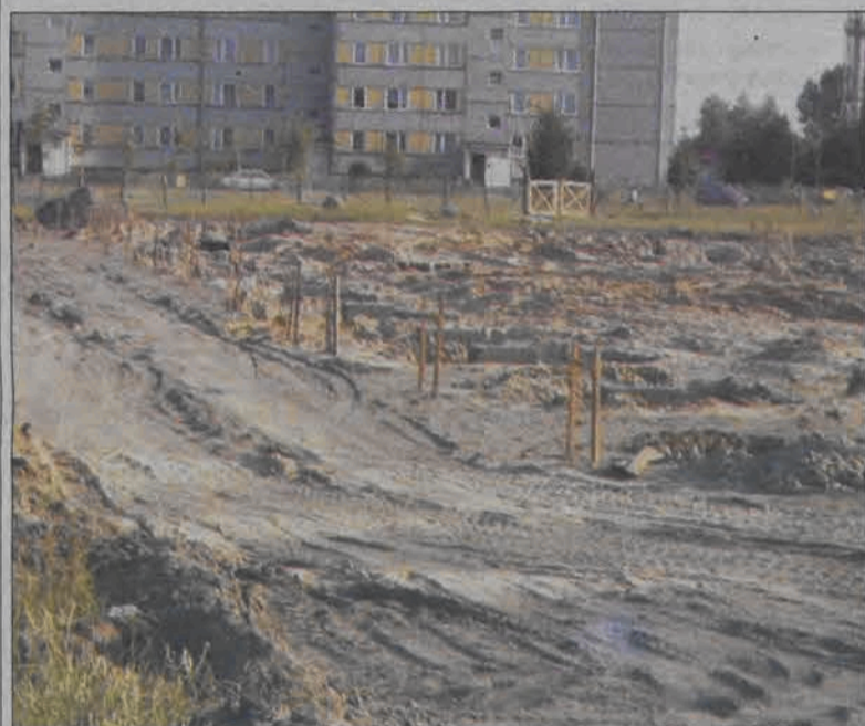
Początek prac przy budowie Centrum Tuszewska na Bratkowicach.
