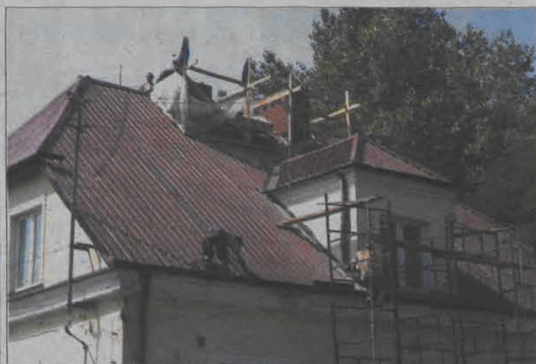
Trwają prace przy konserwacji poszycia dachu, wymiany obróbek blacharskich i rynien na budynku Mazowieckiego Centrum Hodowli i Rozrodu Zwierząt w Łowiczu. Prezes Zarządu Centrum Krzysztof Gajek powiedział nam, że jest to pierwszy krok do podjęcia prac przy remoncie elewacji budynku, prawdopodobnie na jesieni tego roku. Budynek, w którym mieści się Centrum powstał prawie 50 lat temu.
