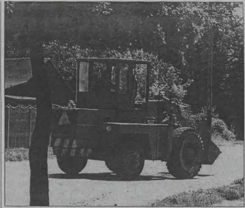
Przedsiębiorstwo Robót Inżynieryjno-Drogowych w Łowiczu rozpoczęło prace przy układaniu nowej nawierzchni asfaltowej na ulicy Katarzynów - na odcinku od skrzyżowania z ulicą Powstańców do przejazdu kolejowego. Kilka dni wcześniej PRID zakończył układanie nawierzchni na ulicy Broniewskiego w Łowiczu. (mak)
