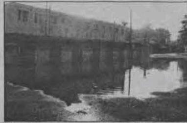
Woda sprzed ogrodzenia klubu trafiała przez bramę na boisko treningowe, zamieniając je w głęboki na kilkanaście centymetrów staw.
