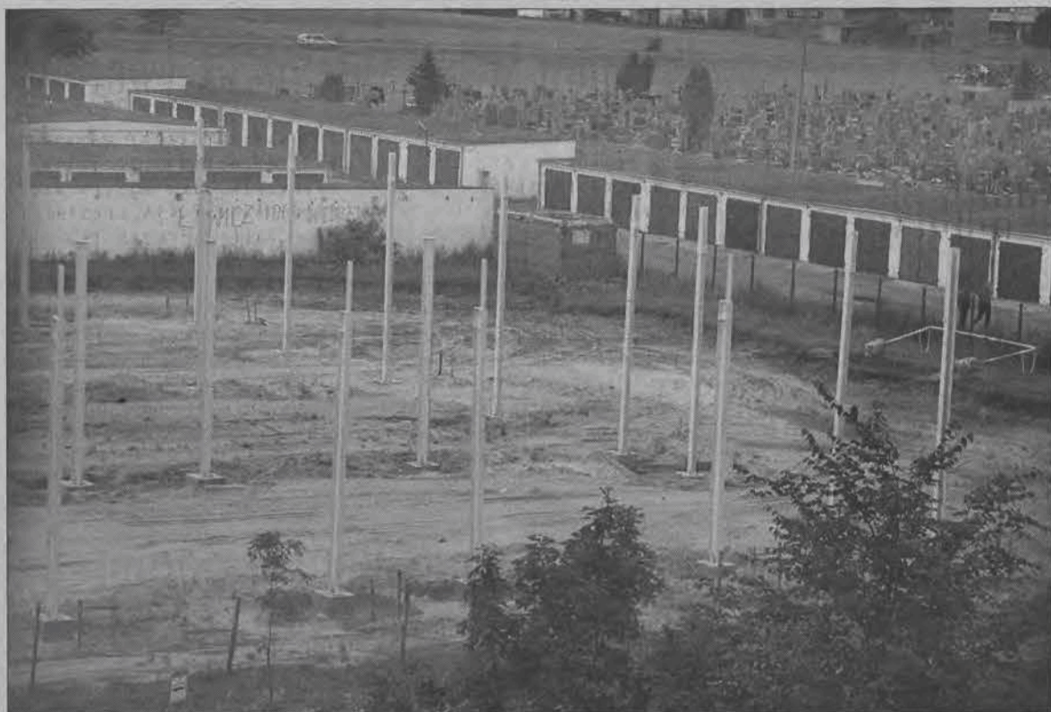
Powstaje już metalowa konstrukcja nowego obiektu o nazwie Centrum Tuszewska na osiedlu Bratkowice w Łowiczu. Wewnątrz ma mieścić się market spożywczy o powierzchni handlowej kilkuset metrów kwadratowych oraz kilka lub kilkanaście mniejszych sklepów z różnym asortymentem. W pobliżu centrum powstanie również parking na co najmniej 70 samochodów. Prace prawdopodobnie przeciągną się na następny rok. (mak)
