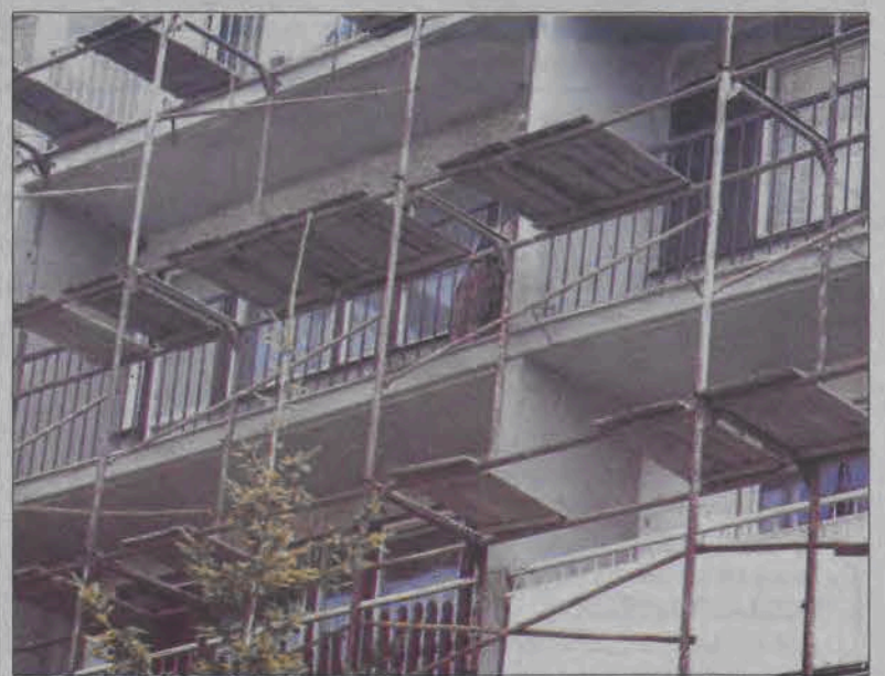
Blok nr 5 na Bratkowicach został poddany remontowi jako pierwszy.
