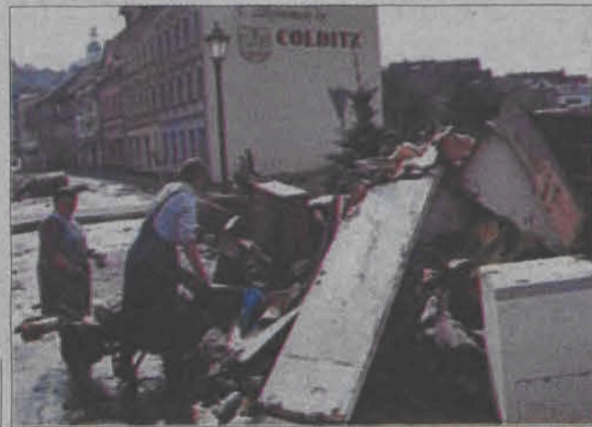
Pierwsze prace przy sprzątaniu tego, co powódź zniszczyła.
