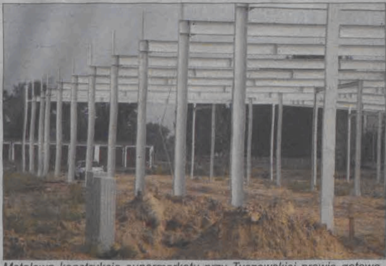
Metalowa konstrukcja supermarketu przy Tuszewskiej prawie gotowa.
