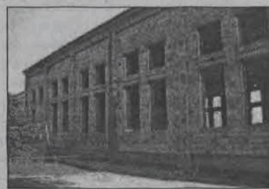
Sala gimnastyczna ma już dach.
