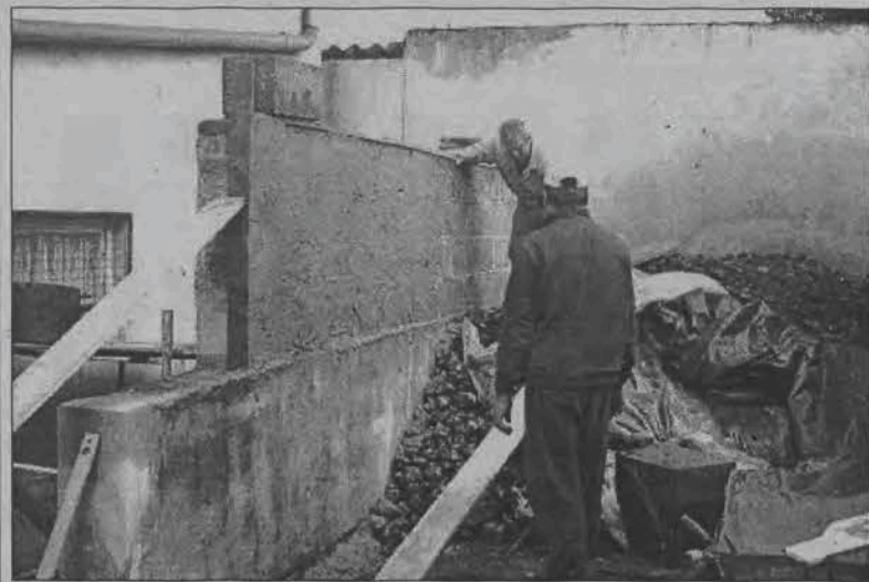
Osadzeni w łowickim więzieniu podczas prac wykończeniowych na terenie przedszkola „Wiosenka”.
