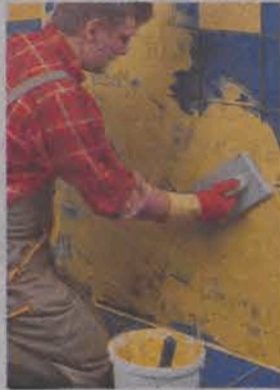
Zaprawę wprowadza się w spoiny przy użyciu gumowej szpachelki lub pacy oklejonej gumą.
