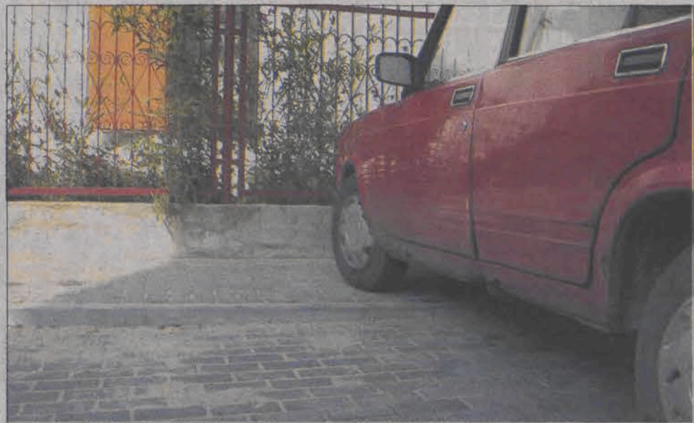
Wiosną tego roku Zakład Usług Komunalnych oddał mieszkańcom osiedla Noakowskiego i Nowego Rynku do użytku ulicę Konopackiego, na odcinku od Kurkowej do skrzyżowania z Ciemną. Mimo urządzenia obszernych miejsc parkingowych okoliczni mieszkańcy parkują często swoje pojazdy przednimi kołami na chodniku. Dyrekcja ZUK apeluje, by tak nie robić, bo podbudowa chodnika nie jest przystosowana do tak dużych obciążeń. (tb)
