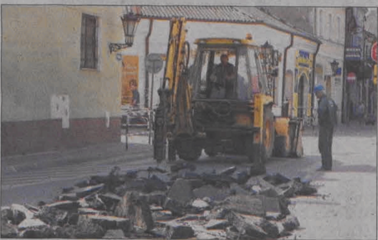
Prace przy modernizacji zachodniej części Zduńskiej oraz Koziej zaczęły się pod koniec czerwca. Na Zduńskiej nie skończyły się do dziś.
