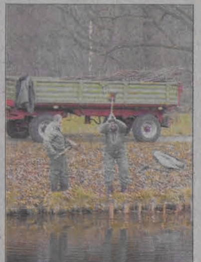
Trwają prace przy umacnianiu brzegów kanału łączącego parkowe stawy.
