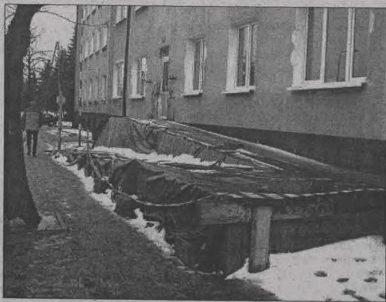
Wjazd do Policyjnego Punktu Informacyjnego nie został jeszcze dokończony z powodu mrozów.
