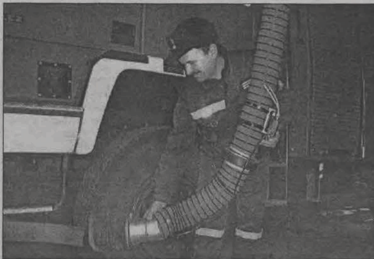
St. sekcijny Ireneusz Sołtysiak podczas dołączania systemu odciągu spalin.
