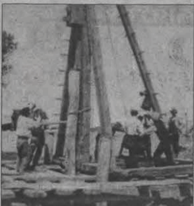
Regulacja Słudwi - wbijanie drewnianych pali mostowych - 1930 r.
