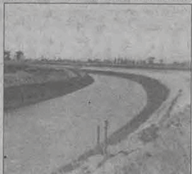
Koryto Słudwi po regulacji - 1932 r.
