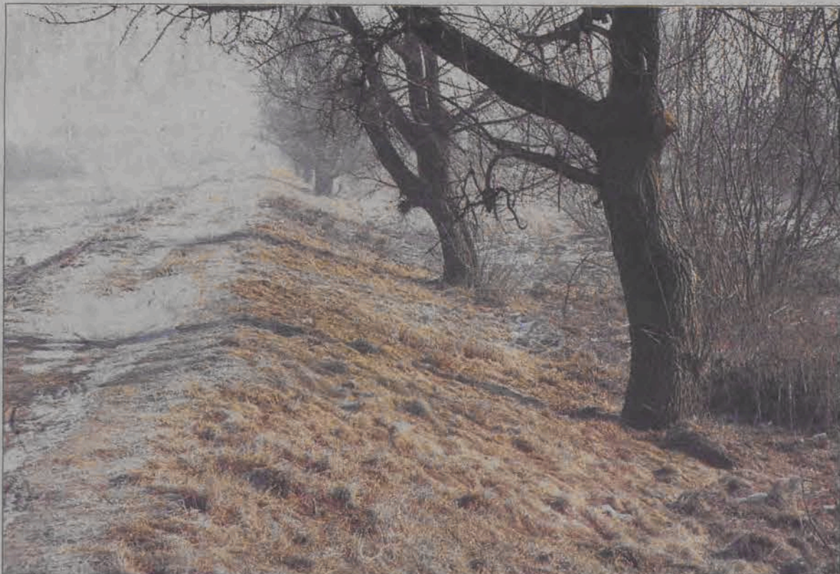
Te drzewa korzeniami uszkadzają podstawę wału, w przyszłości może to mieć katastrofalne konsekwencje.
