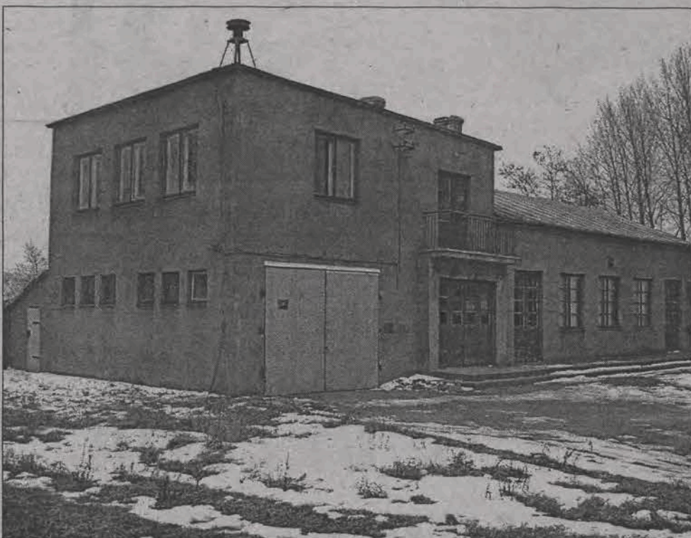
Po remoncie dachu Dom Ludowy w Niedźwiadzie będzie mógł być wykorzystywany przez uczniów tamtejszej podstawówki jako minisala gimnastyczna.
