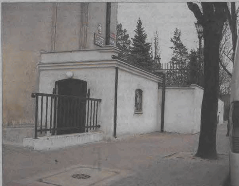
Wejście do piwnic, w których będzie restauracja zbudowano od strony ulicy 3 Maja.
