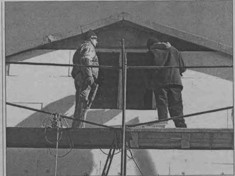
Docieplenie ścian pozwoli ograniczyć wydatki na ogrzewanie.
