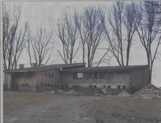
Prace przy przebudowie „Szkielek” szybkim krokiem idą do przodu. Część barowa ma być już otwarta w czerwcu.
