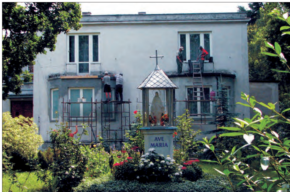
Siostry Miłosierdzia opuszczają Łowicz na dobre. Na ich posesji trwają prace remontowe. Teren należący do zgromadzenia wraz z budynkiem zostanie zapewne sprzedany.
