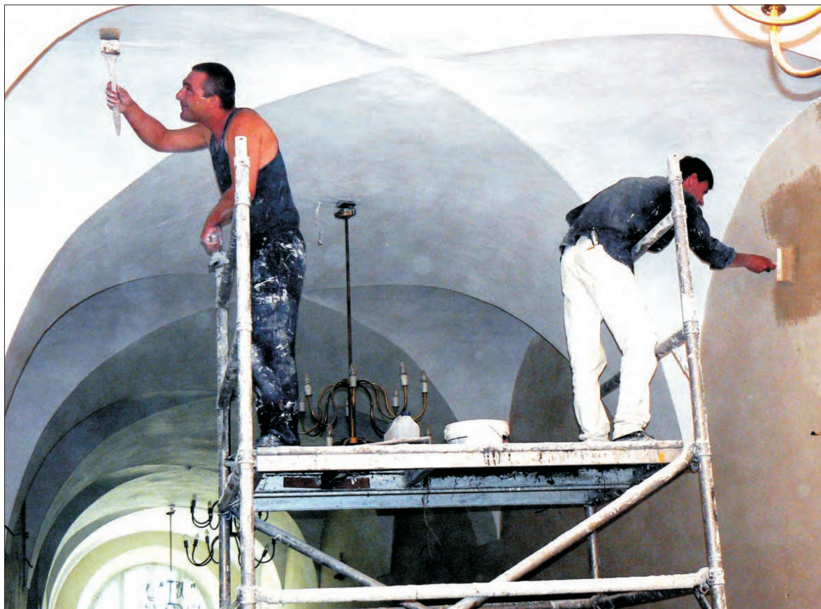
Malowanie holu na Podrzecznej. Firma Abex w ubiegłym tygodniu malowała górny hol w Zespole Szkół Ponadgimnazjalnych nr 1 w Łowiczu. Krzyżowe, łukowe sklepienia wymagały ustawienia rusztowań. Prace trwały po 10 godzin dziennie. Pracownicy gospodarstwa szkoły podczas dyżurów we własnym zakresie malowali natomiast hol na parterze budynku poklasztorowego.
