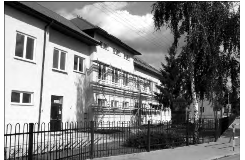
Od strony ulicy elewacja Zespołu Szkół jest już prawie skończona. Od strony boiska zostało jeszcze dużo prac do wykonania.
