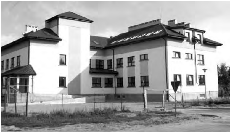
Prace w środku budynku trwać będą do wiosny przyszłego roku.
