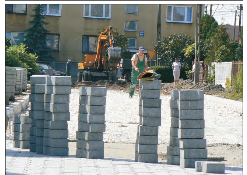
Prace na Ikra nabierają tempa, we wtorek było już ułożonych ponad 10 metrów kostki brukowej.
