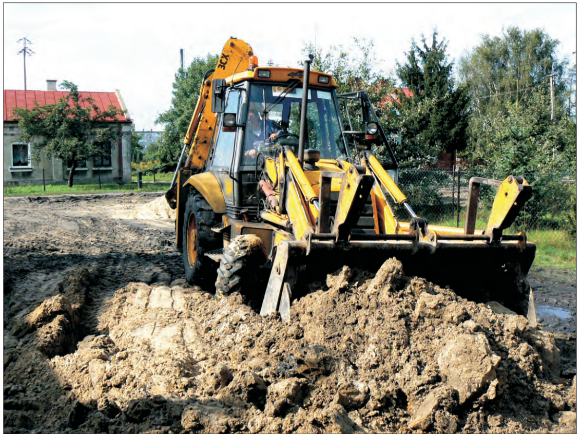
Wykopy do 3 metrów są natychmiast po zakończeniu prac zasypywane - ul. Niciarniana.
