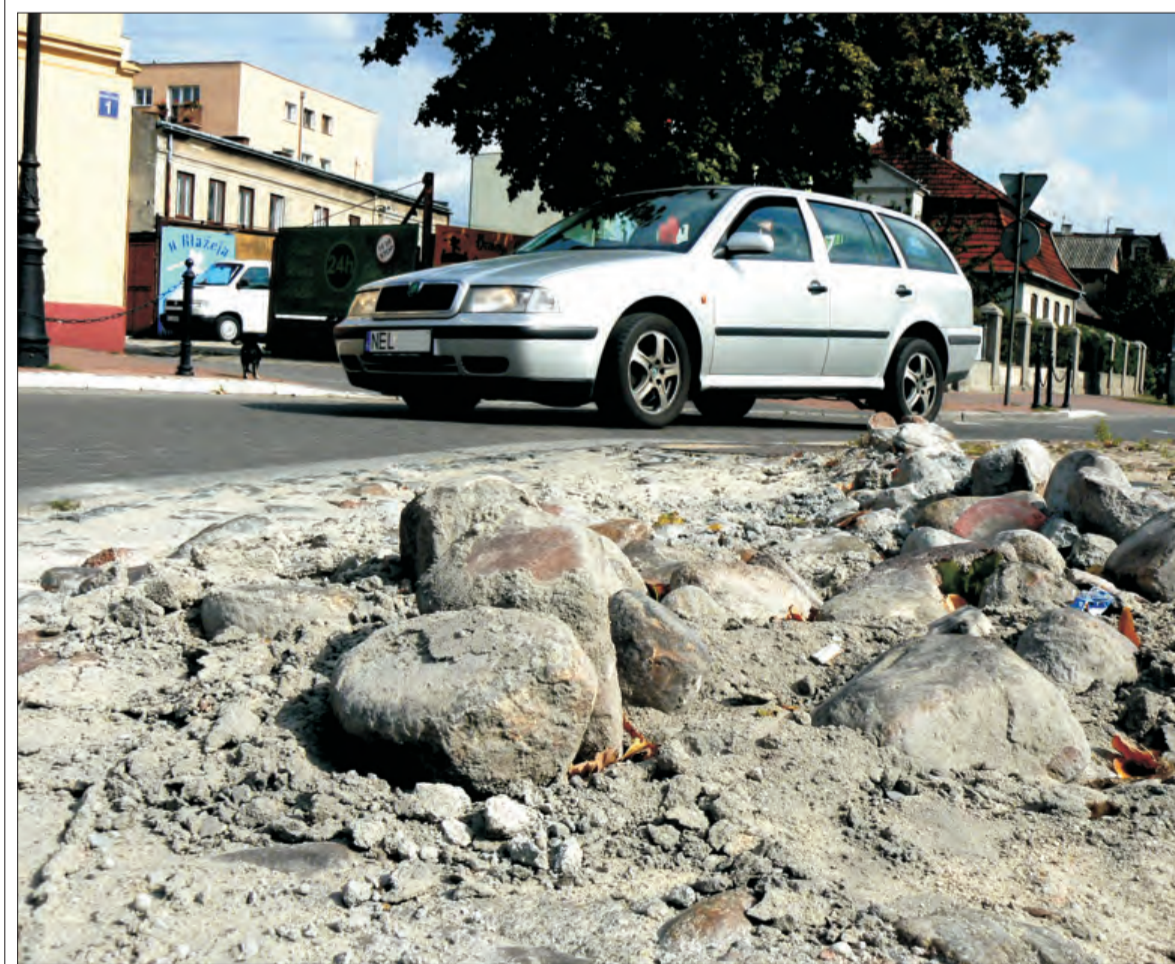
Centralny plac ronda przynajmniej raz w miesiącu jest orany przez koła ciężarowych samochodów.
