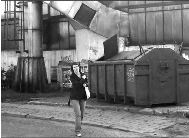
Kotłownie na osiedlu Dąbrowskiego już od kilku lat są niewykorzystywane, w ich cieniu stoją kontenery na śmieci.
