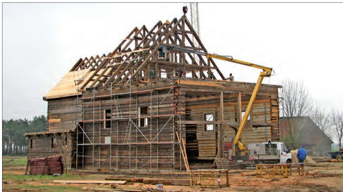
Widać już bryłę kościoła w Maurzycach. Trwają jeszcze prace przy rekonstrukcji ścian oraz dachu.
