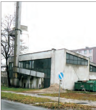
Jedna z niepotrzebnych kotłowni stoi przy skrzyżowaniu ul. Ułańskiej i Wojska Polskiego.
