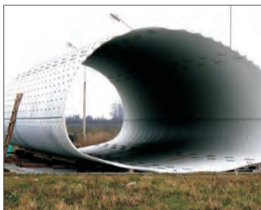
Ta ogromna metalowa „rura” to nowy przepust, który wmontowany zostanie pod mostem w Domaniewicach.
