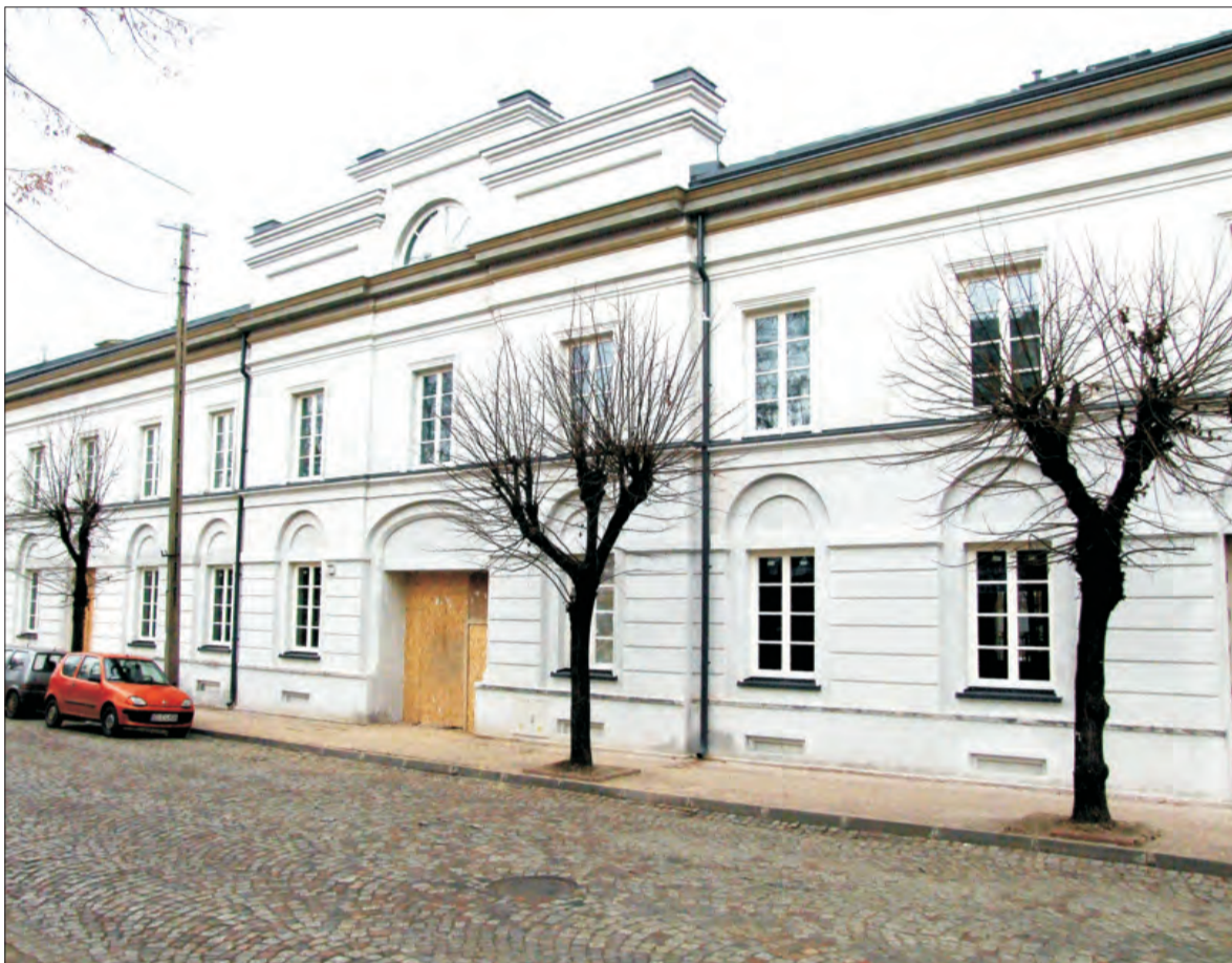
Zniknęły już rusztowania, odnowiony budynek widać w całości.
