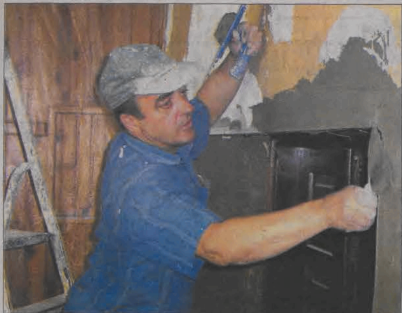
Na sali gimnastycznej także trwają prace remontowe. Firma Józefa Melki z Kutna naprawia tynki, które zostaną pokryte nową warstwą farby na koniec firma zajmie się parkietem.
