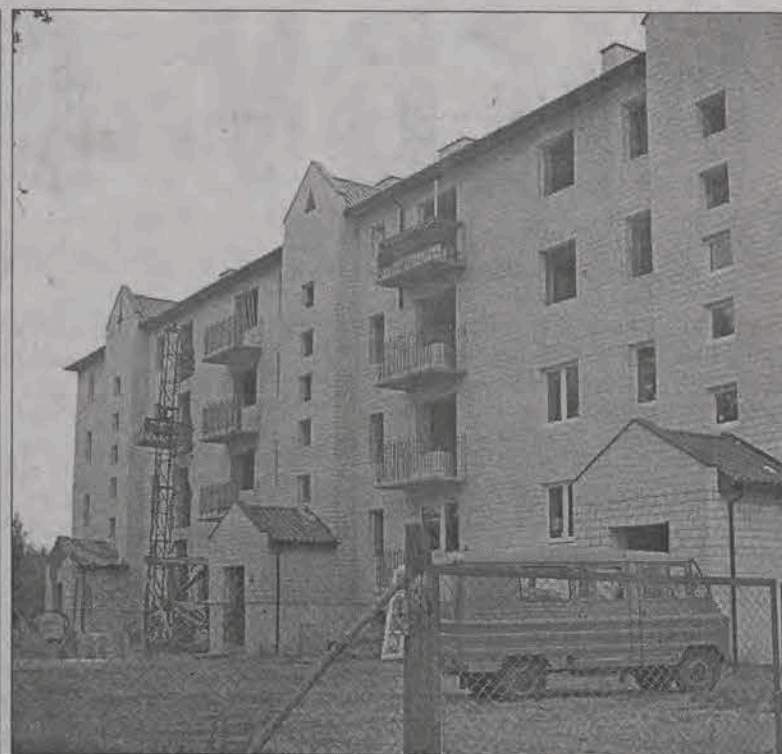
Prace wykończeniowe ciągle trwają. Blok będzie gotowy w październiku.
