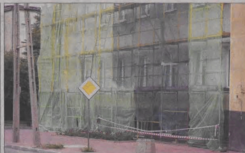
Rusztowania przed budynkiem komendy od strony ulicy Długiej przed rozpoczęciem remontu zasłonięte zostały siatką zabezpieczającą.
