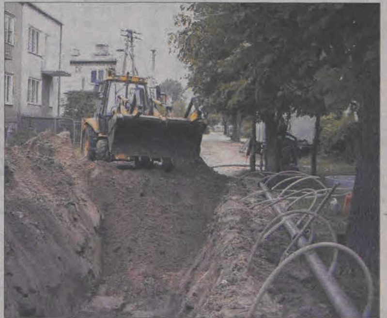
Ostatnie prace na ul. Lipowej.
