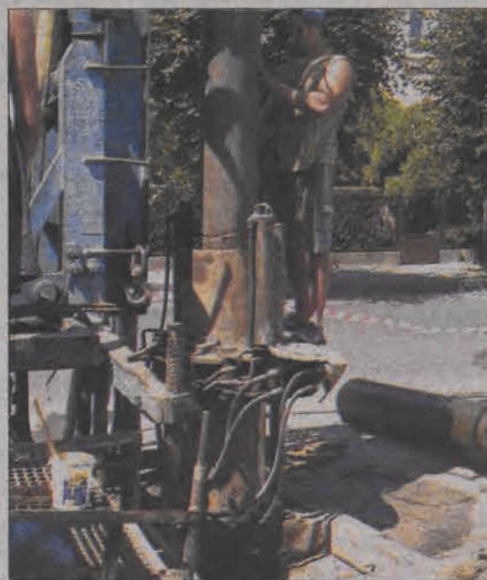
Prace na ulicy Bonifraterskiej.
