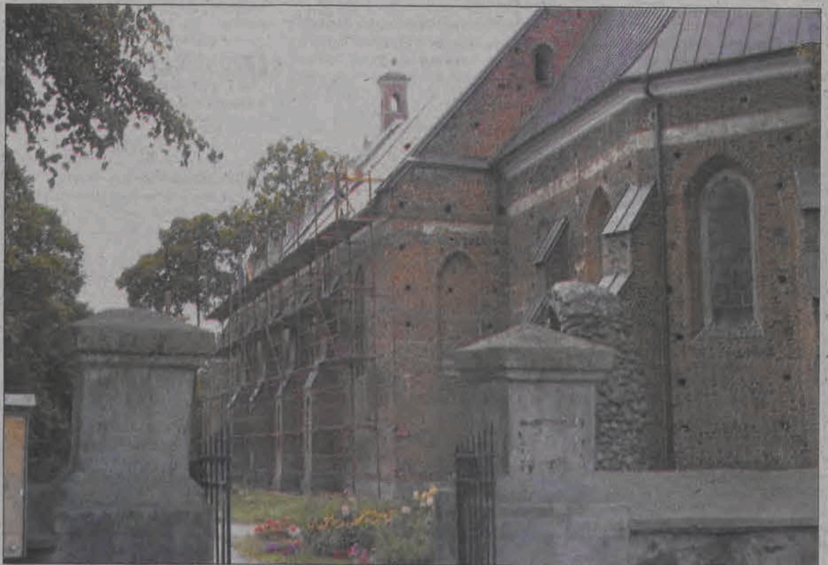
Obecnie układana jest nowa blacha na stronie południowej kościoła w Bielawach.
