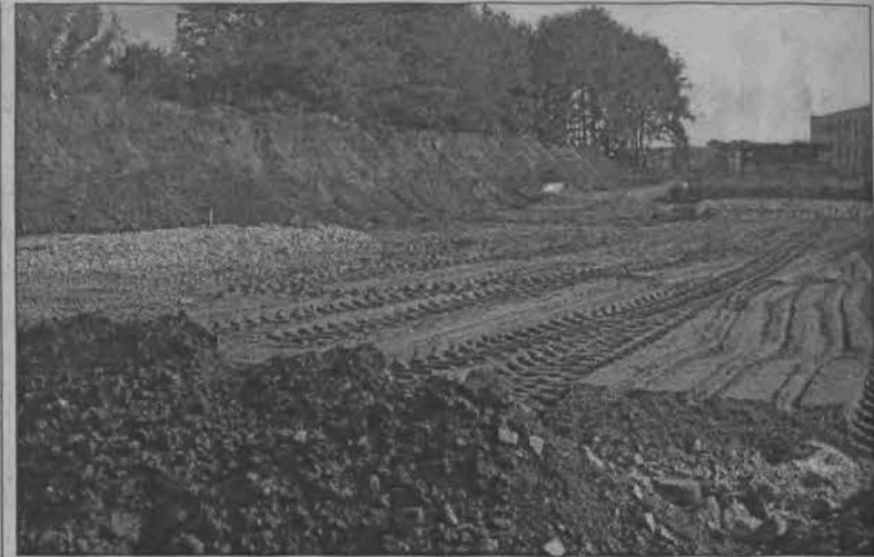
Na tym pustym dotąd terenie trwają intensywne prace. Wkrótce powstanie tu parking i droga dojazdowa do magazynów.
