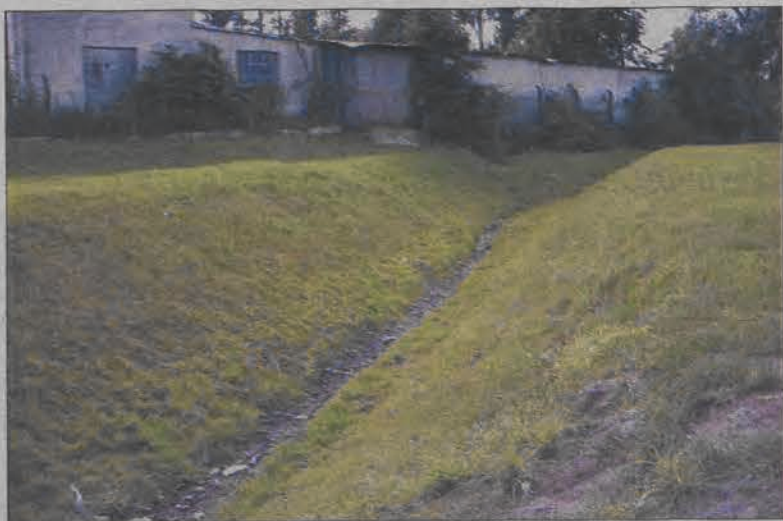
Przez kilka dni w Malinówce prowadzone były prace remontowe.
