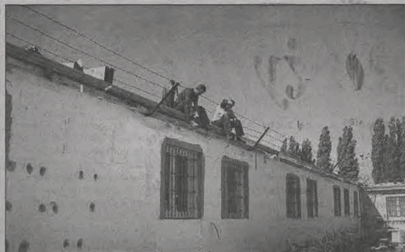
Tak wygląda praca robotników na dachu jednego z budynków zakwaterowania skazanych.
