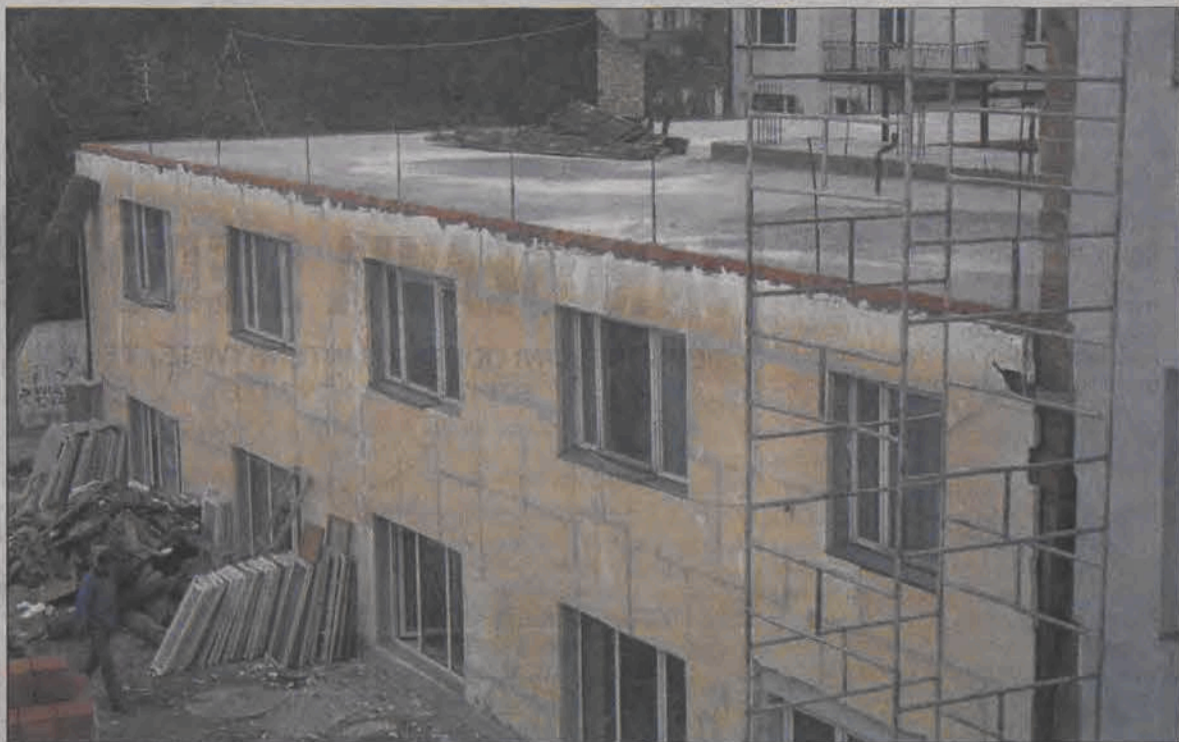
Budynek w którym, po dokończeniu sklepienia, prace będą kontynuowane.
