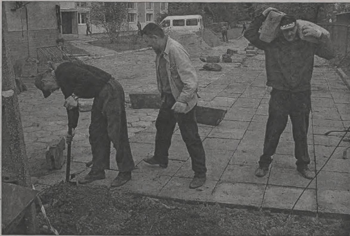
Łowiccy więźniowie zostali zaangażowani do prac przy układaniu płyt chodnikowych pod parking.
