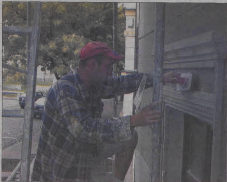
Prace wykończeniowe przy oknach i piętra.
