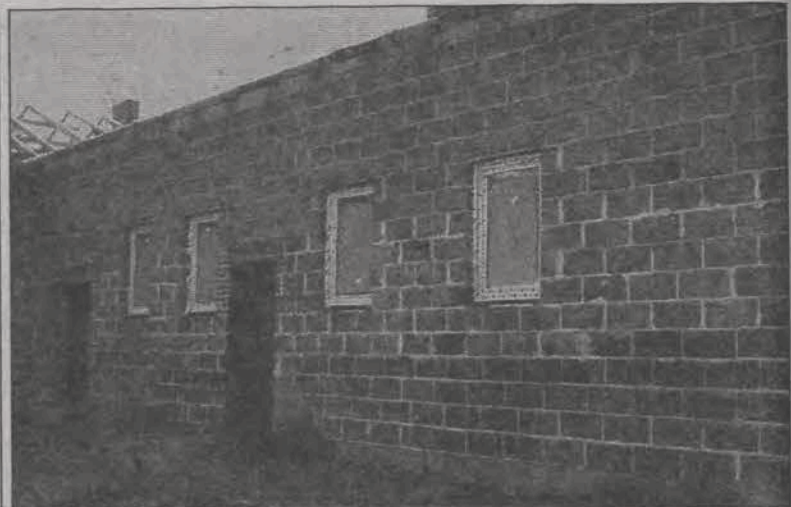
W części garażowej okna są już założone. Reszta zostanie zamontowana w najbliższym czasie.
