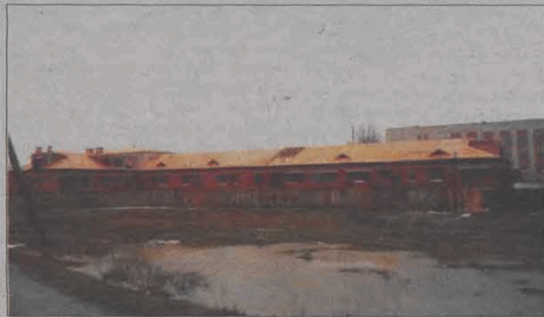
... a tak plac budowy.
