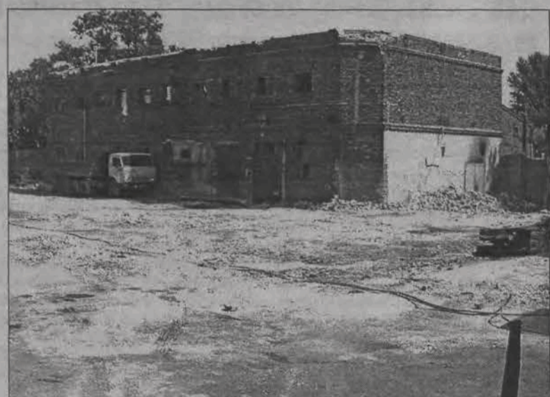
Teren zajmowany przez Spółdzielnię Przemysłu Drzewnego jest już praktycznie bez zabudowań, w których odbywała się produkcja.
