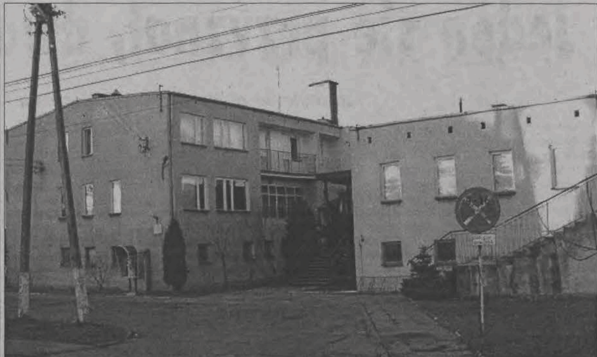
Ośrodek zdrowia w Kiernozi to duży budynek, który wymaga już remontów. Byłoby łatwiej je przeprowadzać, gdyby właścicielem była gmina.
