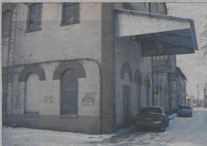
Wkrótce budynki paszarni opustoszeją, jednak co do dalszego ich losu decyzja jeszcze nie zapadła.
