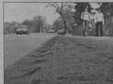
Przy Zakładzie Energetycznym na ulicy Mostowej piach zasłonił dawno krawężnik i wyznacza granicę pomiędzy chodnikiem i jezdnią.
