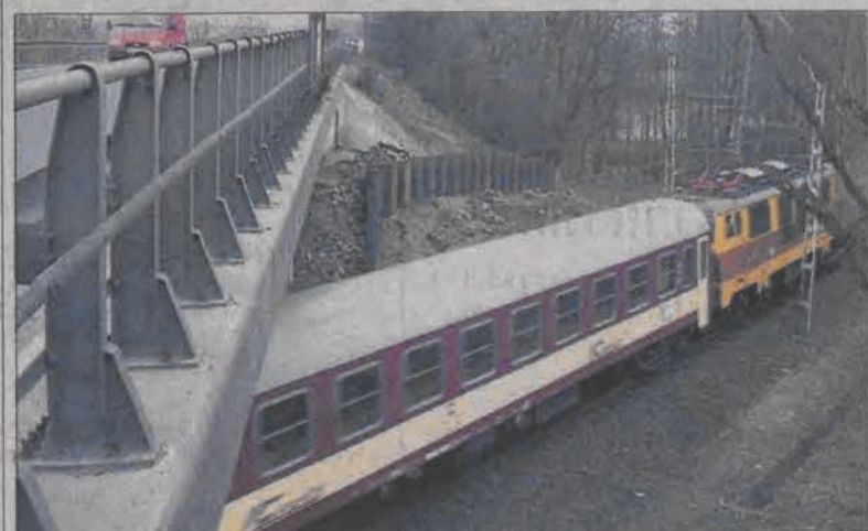
Remontowane torowisko pod wiaduktem zabezpieczone zostało metalowymi osłonami wbitymi w grunt na głębokość około dwóch metrów.
