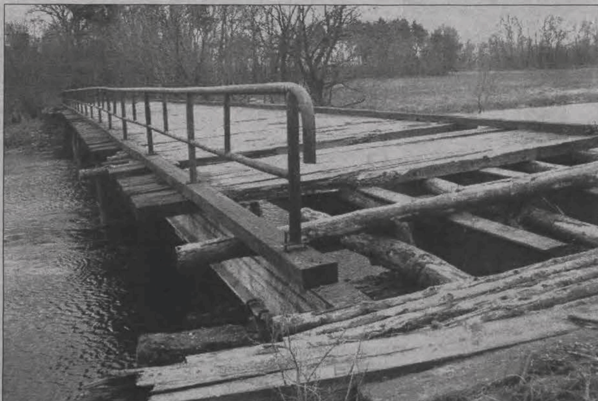
Tak obecnie wygląda most na Bzurze w Popowie dojeżdżając do rzeki od strony trasy poznańskiej.
